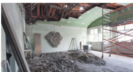
Umbau im Dachgeschoss (Hofgebäude)
